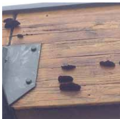
Poutres de la MIEL attaquées par des champignons
