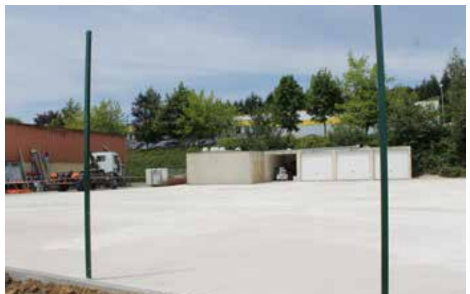
En cours de séchage
