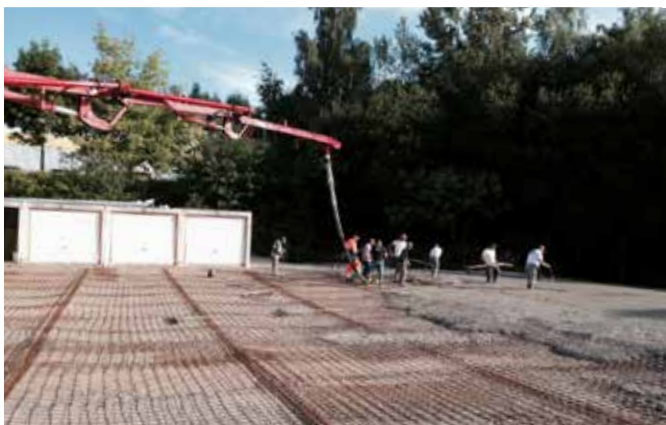
En phase coulage de la plateforme
