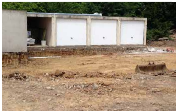
Début des travaux
