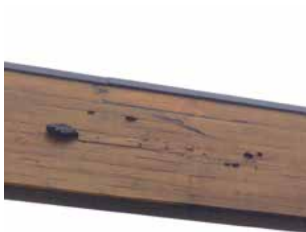
Poutres de la MIEL attaquées par des champignons
