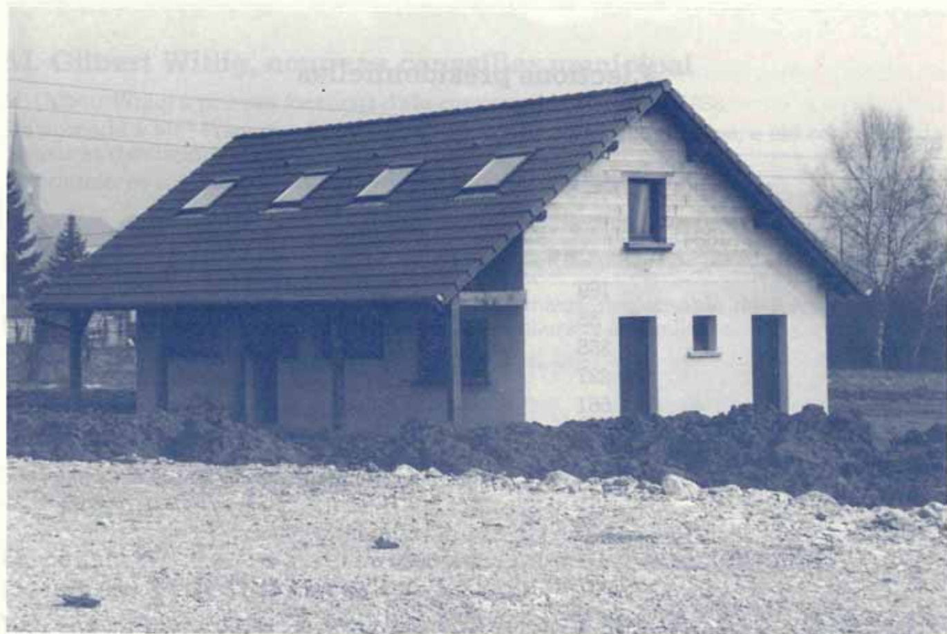
Le vestiaire du complexe sportif.
