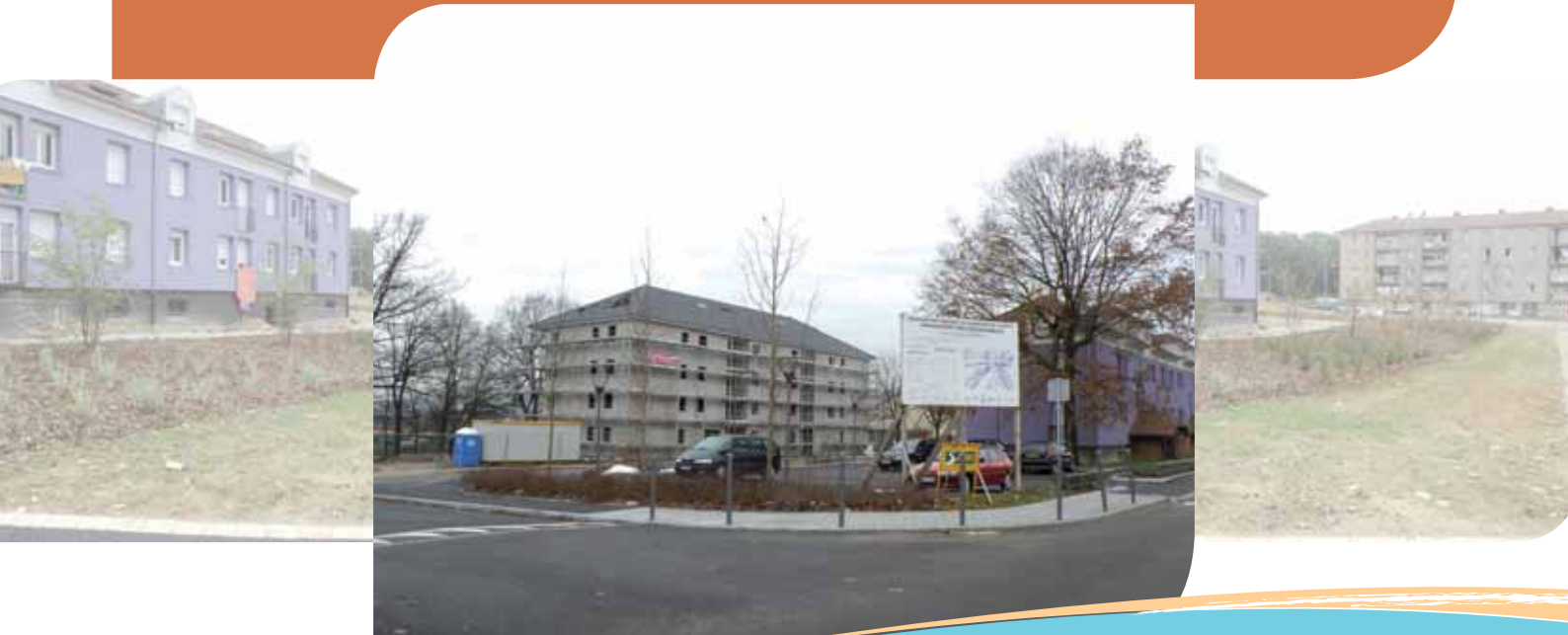
Construction d'un nouvel immeuble
