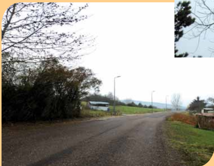
Pose de candélabres, rue sous la Miotte
