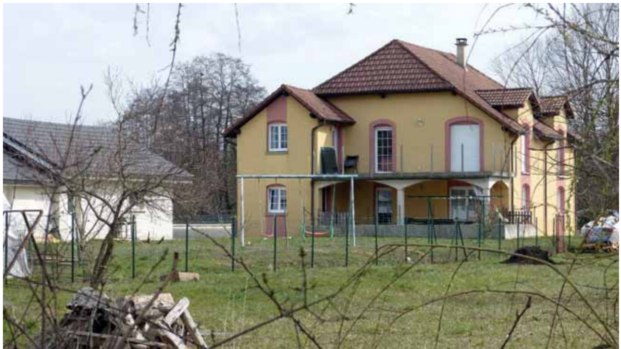
Figure 22 : Zone pavillonnaire avec remblai à l'est de la zone humide - Source : IAD 2021.
