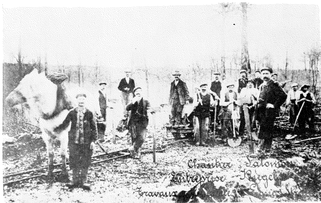
Le Chantier SALOMON - Lignes du Stratégique menant au Fort de Roppe
