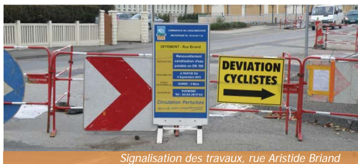
Remplacement de la canalisation d'eau potable, rue Aristide Briand
