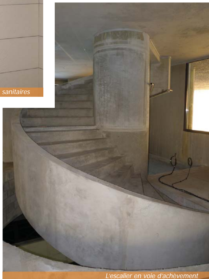
Structure de l'escalier qui relie les deux salles de l'espace artistique
