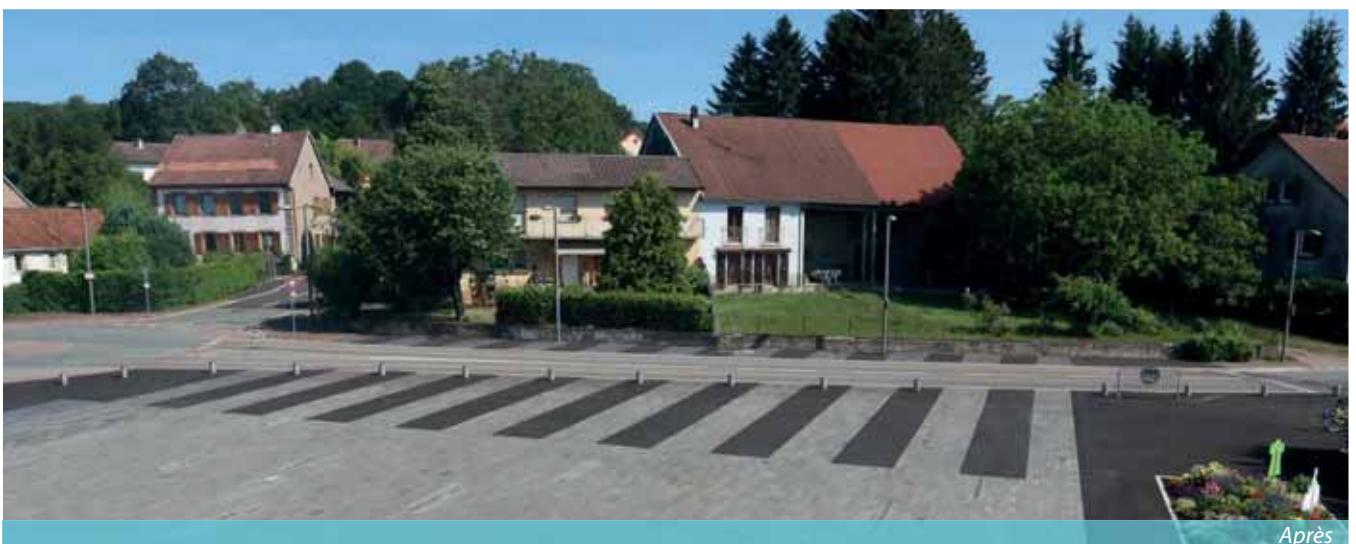
Pendant les travaux
