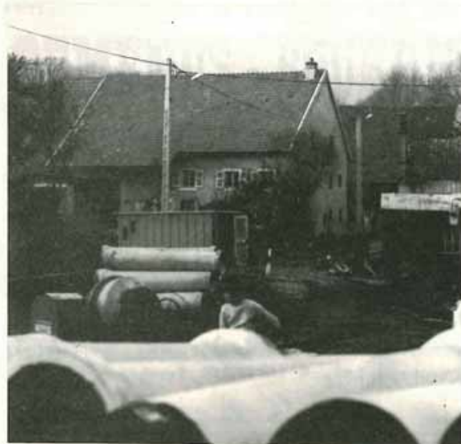
Tuyaux pour la couverture du ruisseau de la Rue des Cerisiers
