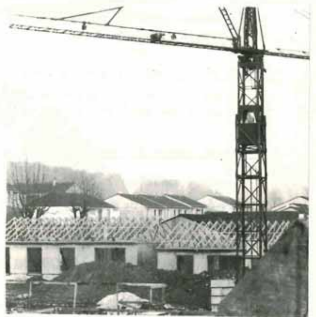
Construction des pavillons H.L.M. aux anciennes casernes
